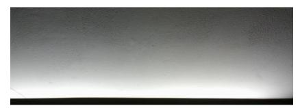
Pour une ligne de lumière continue, distance max entre les luminaires 130mm.
